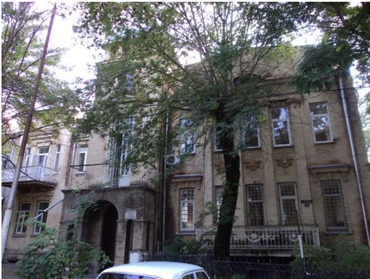
Вид главного фасада памятника
