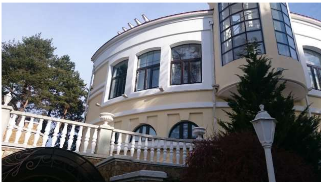
Вид дворового фасада памятника
