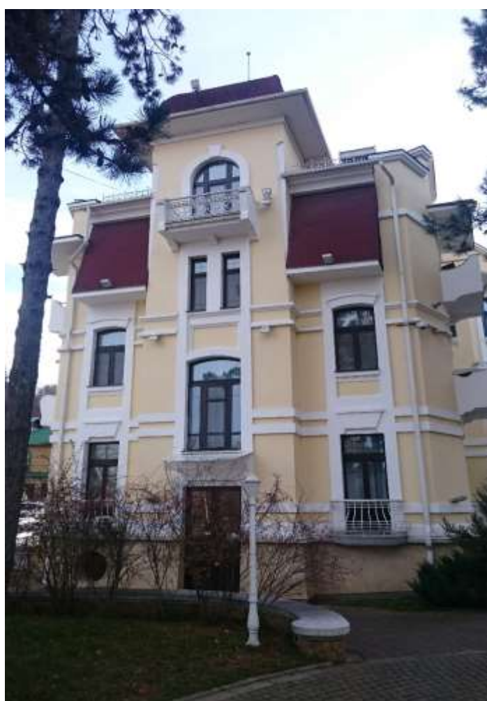
Вид северного фасада памятника
