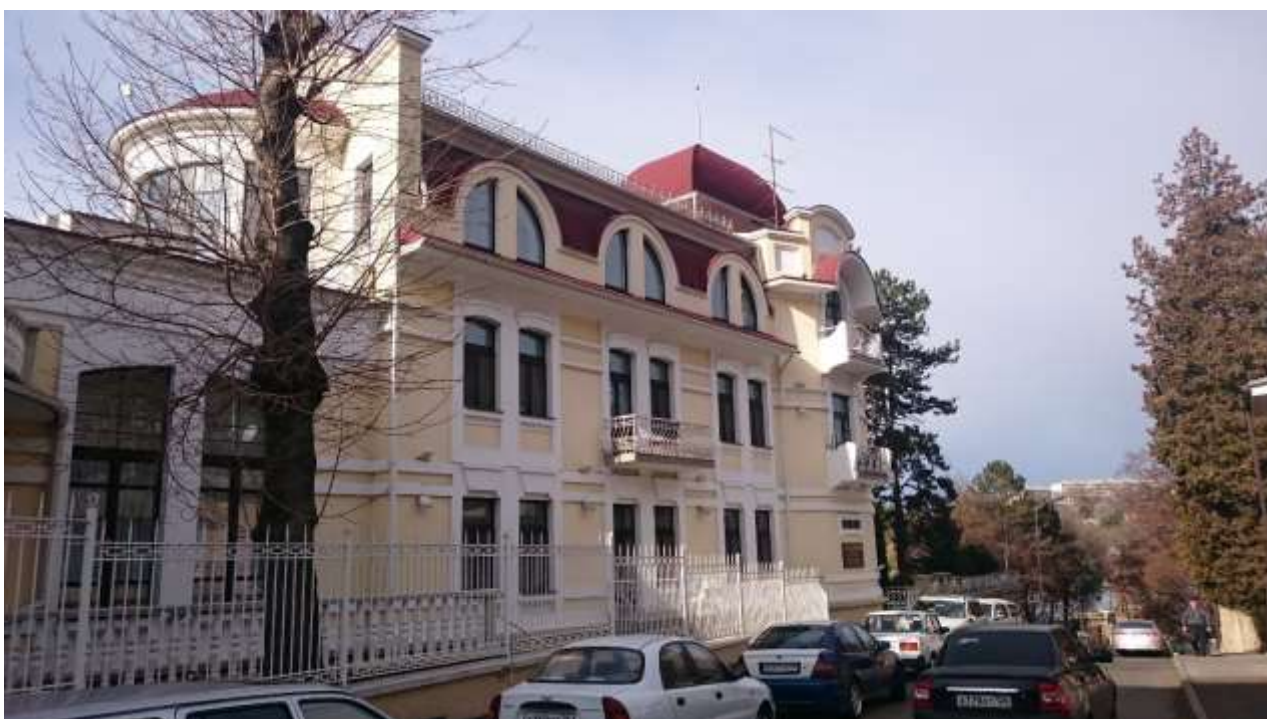
Вид главного фасада памятника
