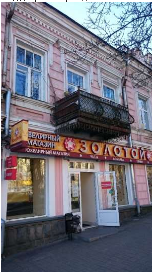
Вид балкона главного фасада памятника
