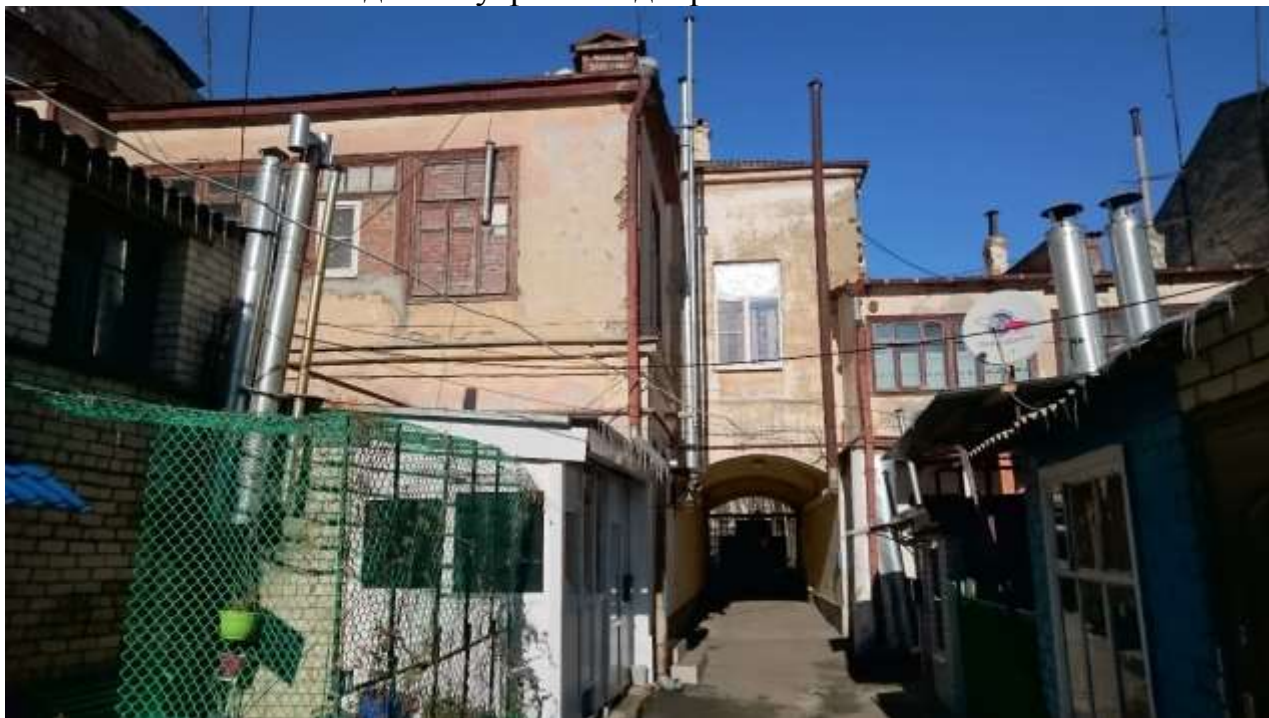
Вид дворового фасада памятника
