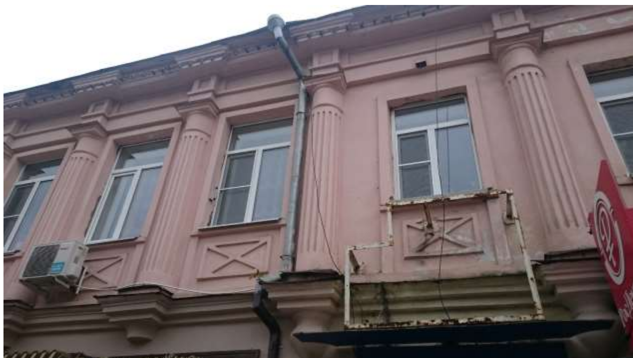
Вид оконных проемов со стороны главного фасада памятника
