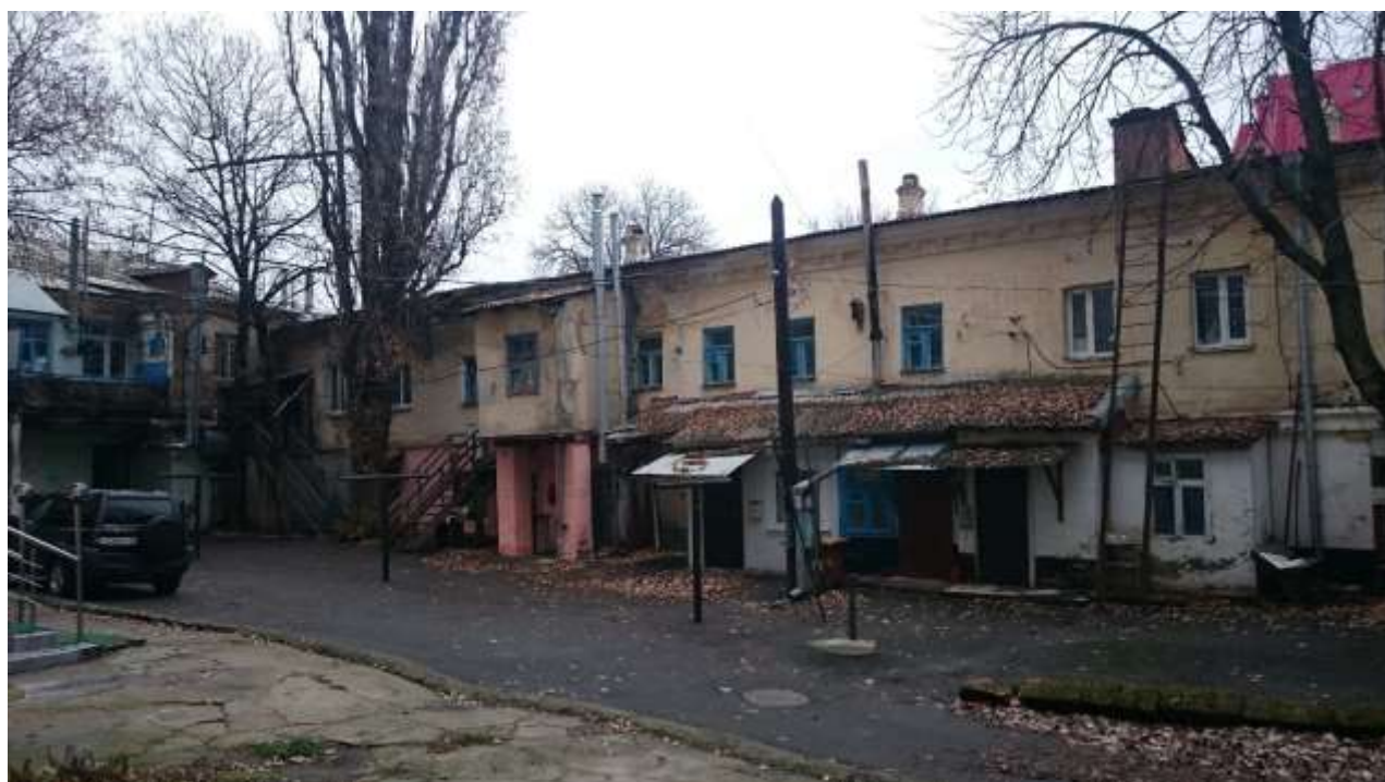
Вид дворового фасада памятника
