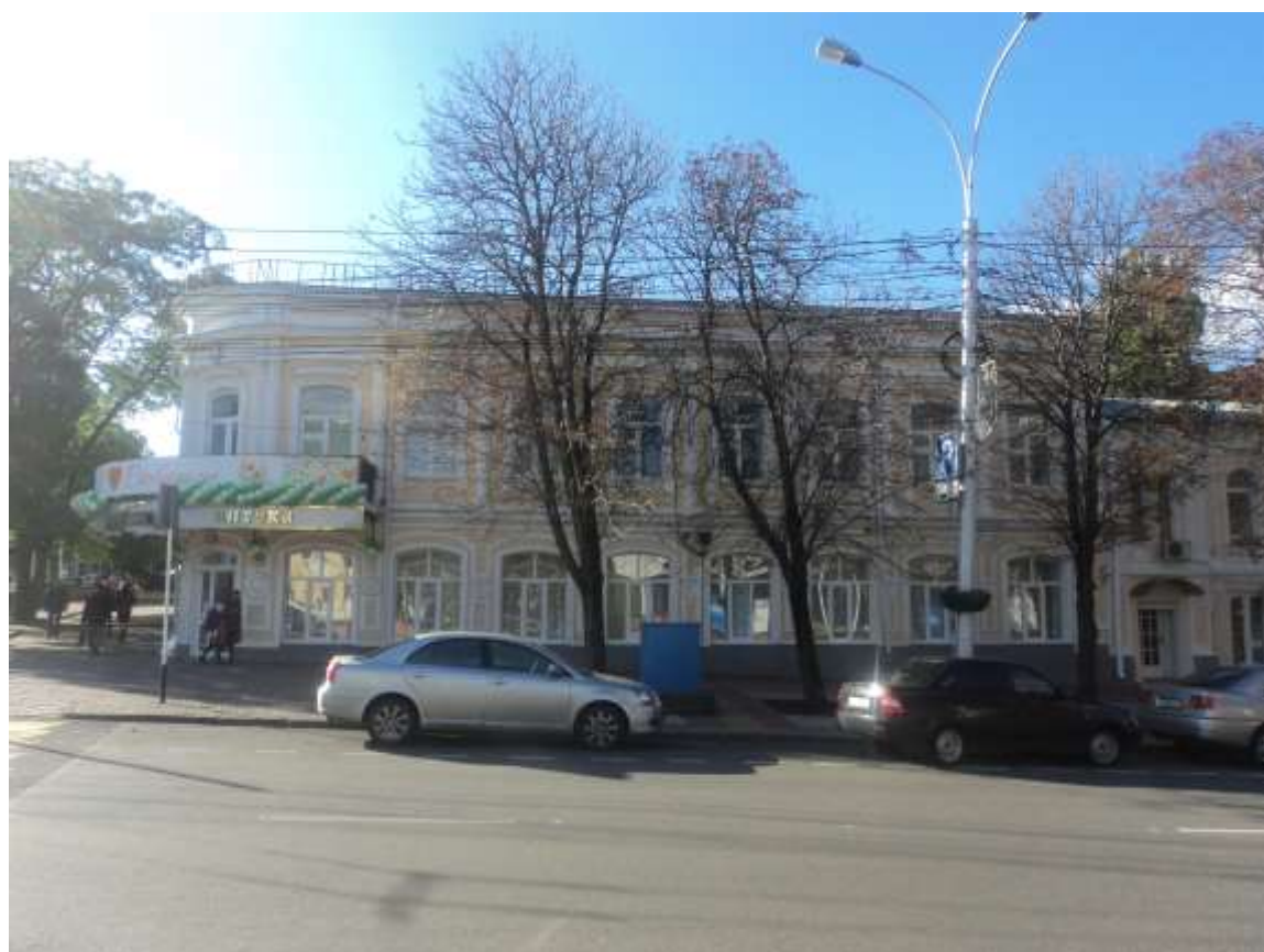
Вид восточного фасада памятника «Аптека»
