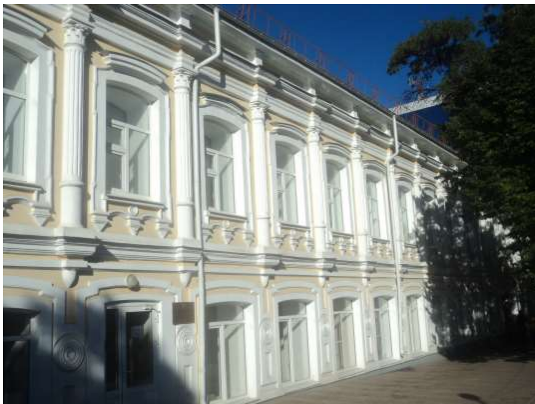
Вид северного фасада памятника «Аптека»
