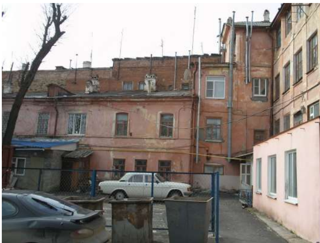
Вид дворового фасада памятника
