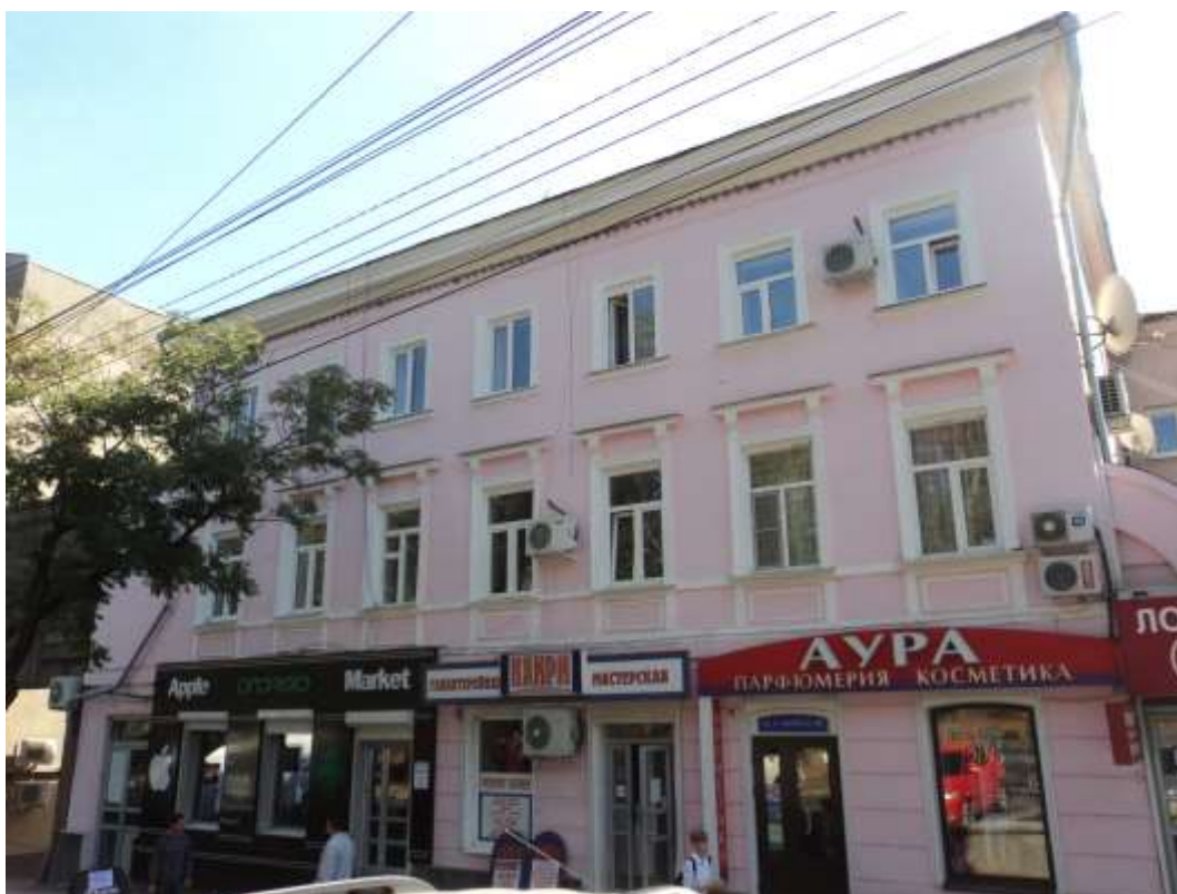
Вид северного фасада памятника
