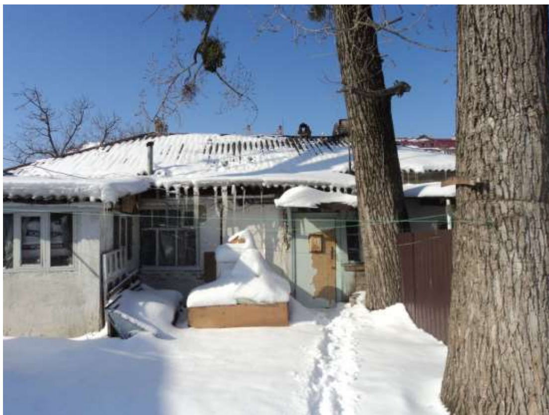
Вид дворового фасада памятника
