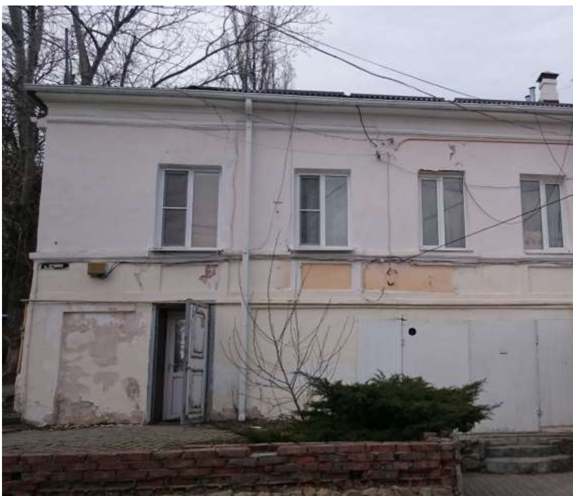
Вид входа в помещения № 31,32,119 памятника
